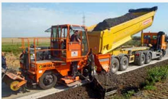
Remblayage, damage et balayage: ce finisseur Midland réalise ces trois opérations en même temps.
