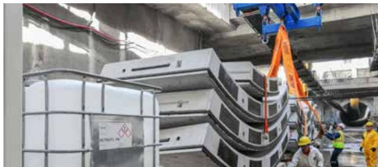
Les voussoirs en béton armé, d'un poids de plusieurs tonnes, et l'agent moussant sont amenés à la tête d'abattage.
