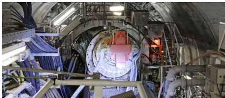
Pose des voussoirs à l'arrière de la tête d'abattage après application du mastic d'étanchéité TNL18.
