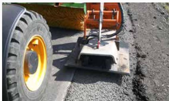
Le damage de l'accotement met les systèmes hydrauliques et le vibreur à rude épreuve.
