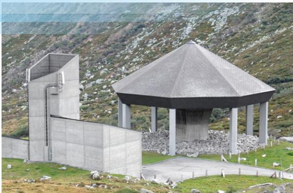
526 Meter oberhalb des Ventilators Nr. 21 befinden sich auf dem Gotthard der Ab- und Zuluftkamin.
