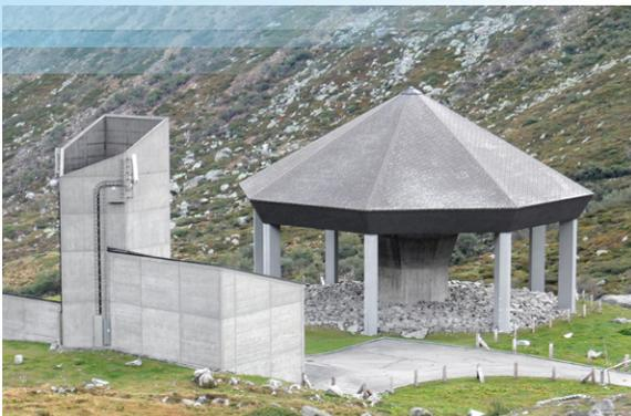
La cheminée d'amenée et d'extraction se trouve sur le massif du Gothard, à 526 m au-dessus du ventilateur n° 21.
