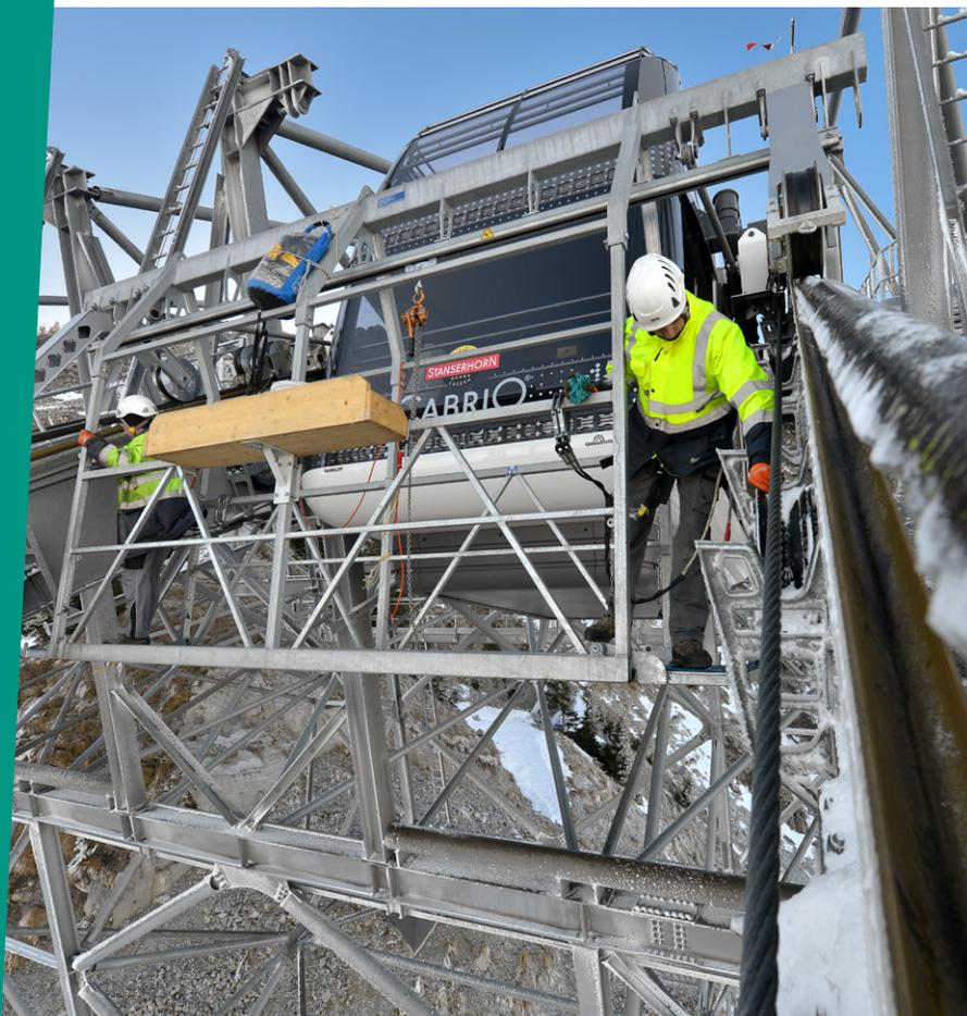
Vom Instandhaltungsfahrzeug aus können Unterhaltsarbeiten an den Tragseilen und Stützen sicher ausgeführt werden.
