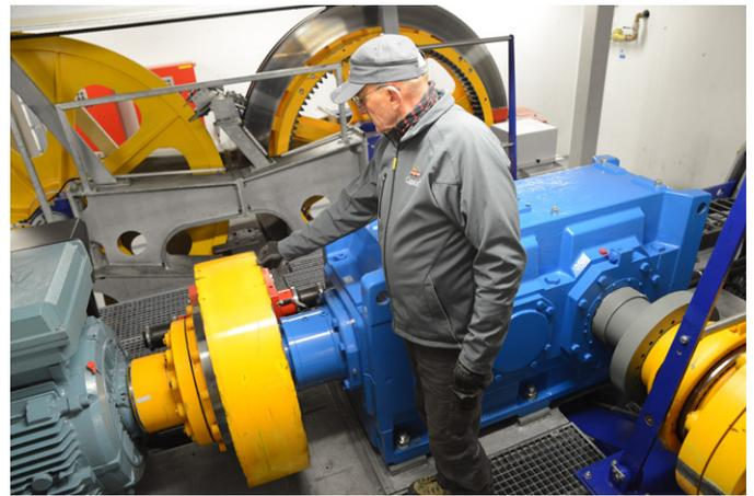
Kabinen ohne Fangbremsen: Gebremst wird hydraulisch auf eine armdicke Bremssscheibe auf der Antriebswelle.
