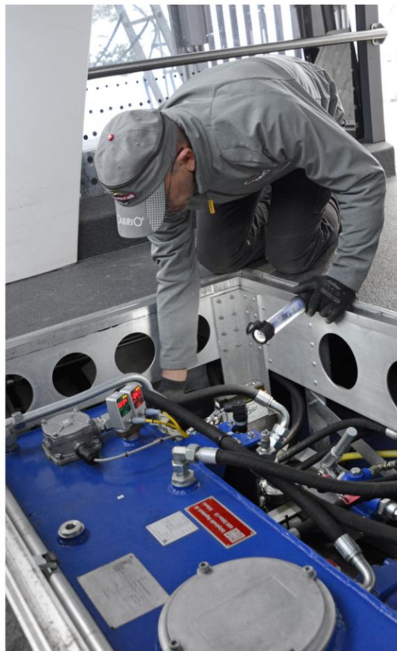
Noldi Flury überprüft die Hydraulikanlage, welche die beiden für den Niveuausgleich zuständigen Zylinder versorgt.
