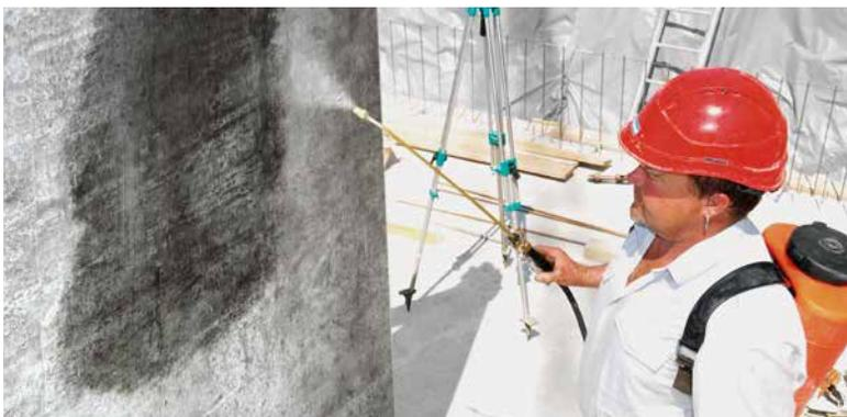
Das gewissenhafte Einsprühen der Schalung mit einem dünnen Trennmittelfilm garantiert das perfekte Ablösen nach dem Trocknen.
