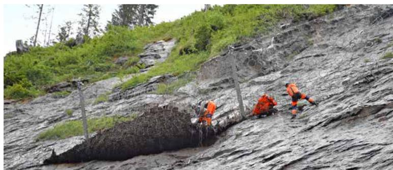
Das Entleeren, Öffnen und Schliessen der Steinschlagnetze erfordert höchste Konzentration und absolute Schwindelfreiheit.
